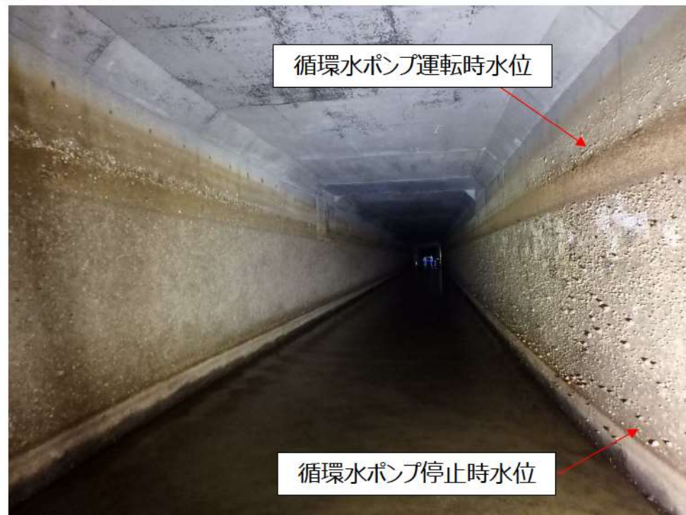
図7 1号炉放水路状況（2023年2月）
