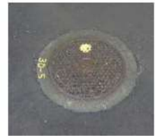
マンホール蓋
