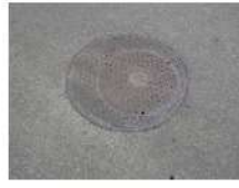
マンホール蓋
