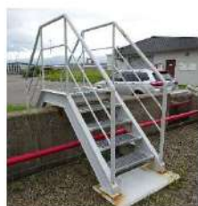
階段（H鋼製）
