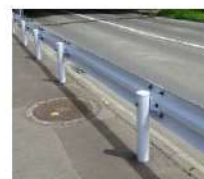
ガードレール
