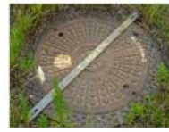
マンホール蓋
