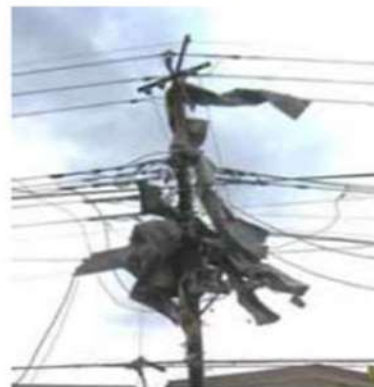
飛散した折板屋根の状況
