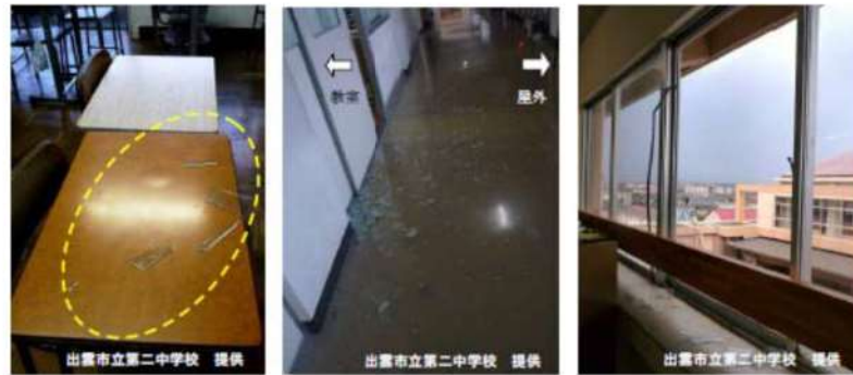
(1) 教室 (2) 廊下 (3) 屋外に面した窓ガラス
