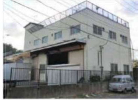
屋上フェンスの被害
