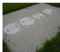
マンホール蓋
