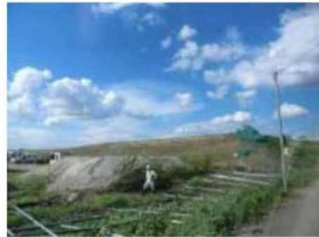
フェンスの被害
