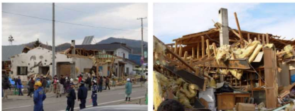
(電柱の折損，傾斜)
