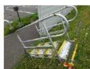
階段（単管パイプ製）
