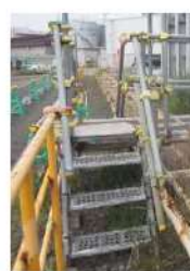
階段（単管パイプ製）
