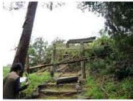
倒木の折損と鳥居の被害
