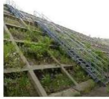
階段（H鋼製）
