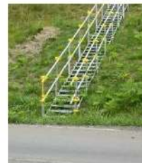
階段（単管パイプ製）
