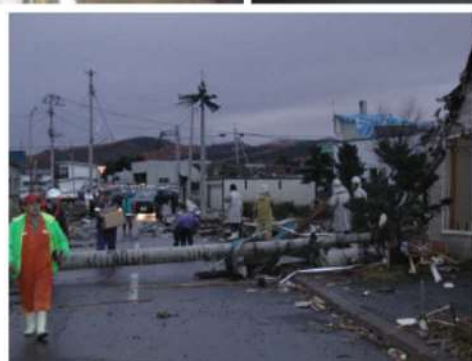
(電柱，道路標識の折損)
