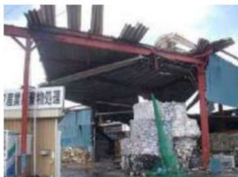
折板の損傷
