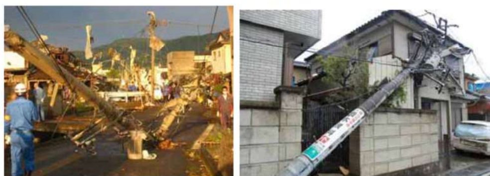
(電柱の折損, 傾斜)
