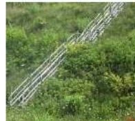
階段（単管パイプ製）
