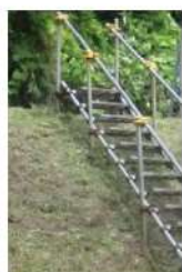
階段（単管パイプ製）
