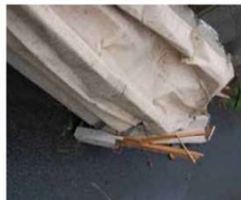
飛散した折板屋根の状況
