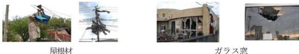
図1 平成24年5月6日 茨城県つくば市で発生したF3竜巻による建築物の被害状況※1
