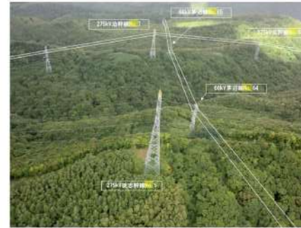
第2.2.3.5図 ③交差箇所の現地状況 (1/3)
