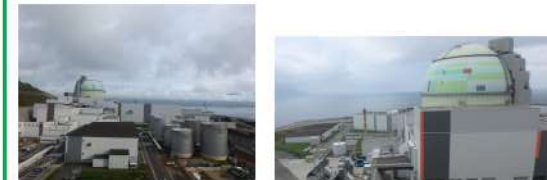
2号炉タービン建屋屋上
