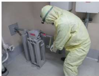
アニュラス排気ダンパ現場手動操作 (原子炉補助建屋 T.P. 40.3m)
