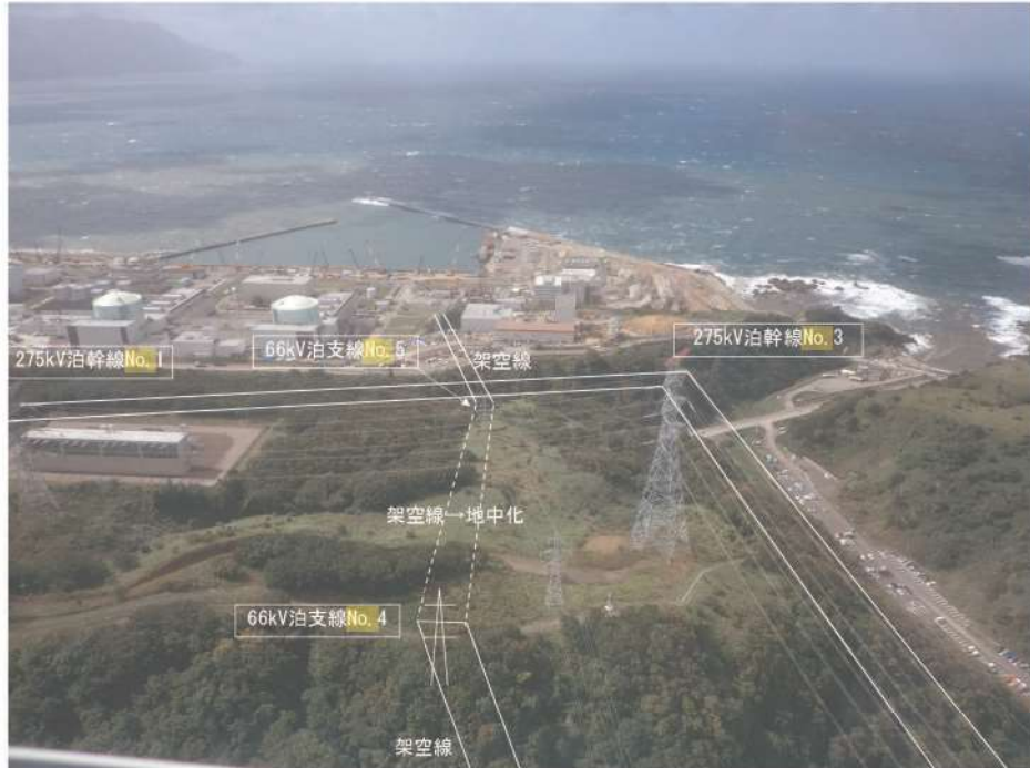
第 2. 2. 3. 4 図 ②交差・近接箇所の現地状況（1/3）
