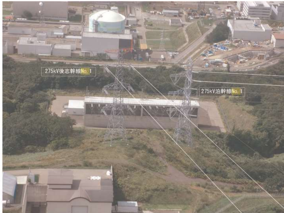
第 2.2.3.3 図 ①近接箇所の現地状況（1/3）
