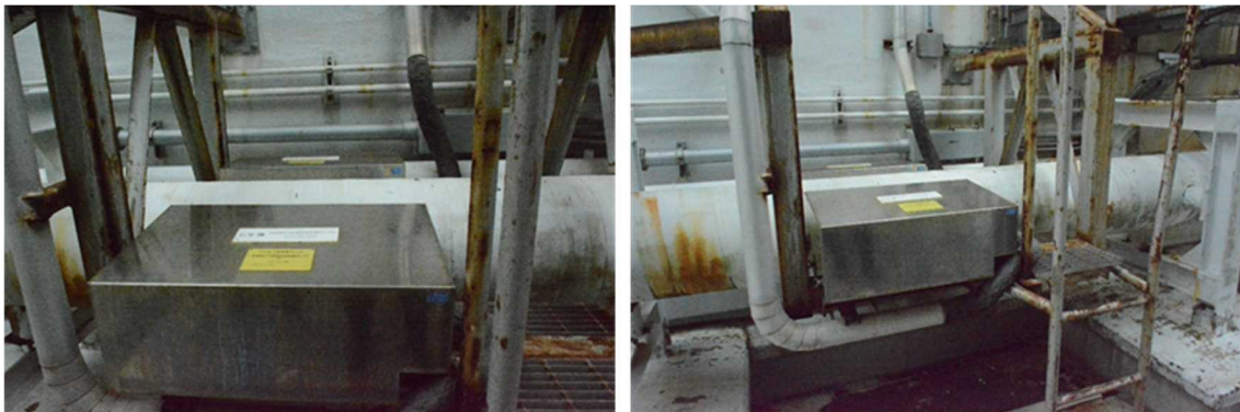
図5 6号機非常用ガス処理系排ガス放射線モニタの外観
