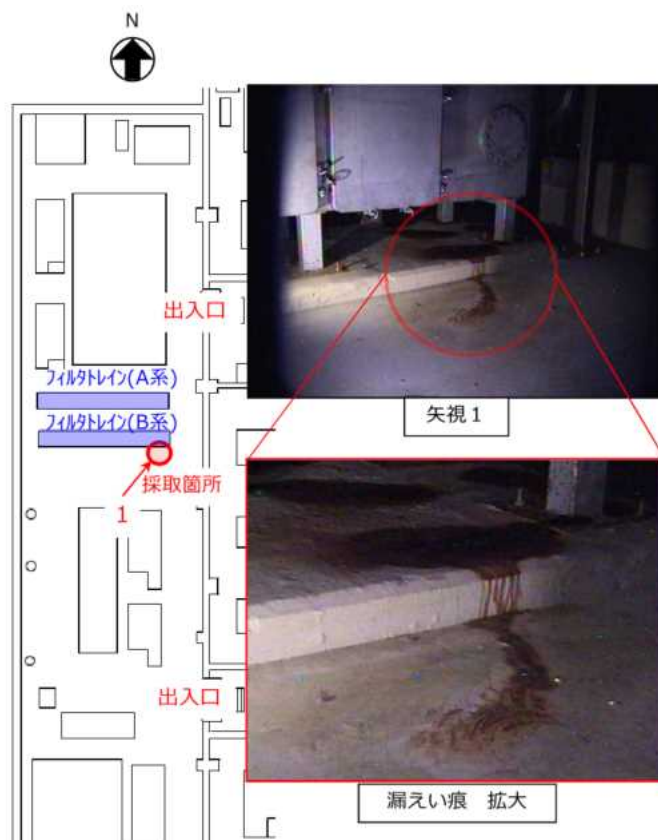
図2 2号機 SGTS フィルタトレイン付近の漏えい痕
