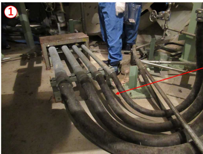
図 1 再循環ポンプ動力ケーブル（CV ケーブル）の設置状況
