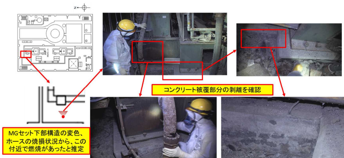
図11 MGセット(A)の西側(下部構造及びコンクリート基礎)の状況
