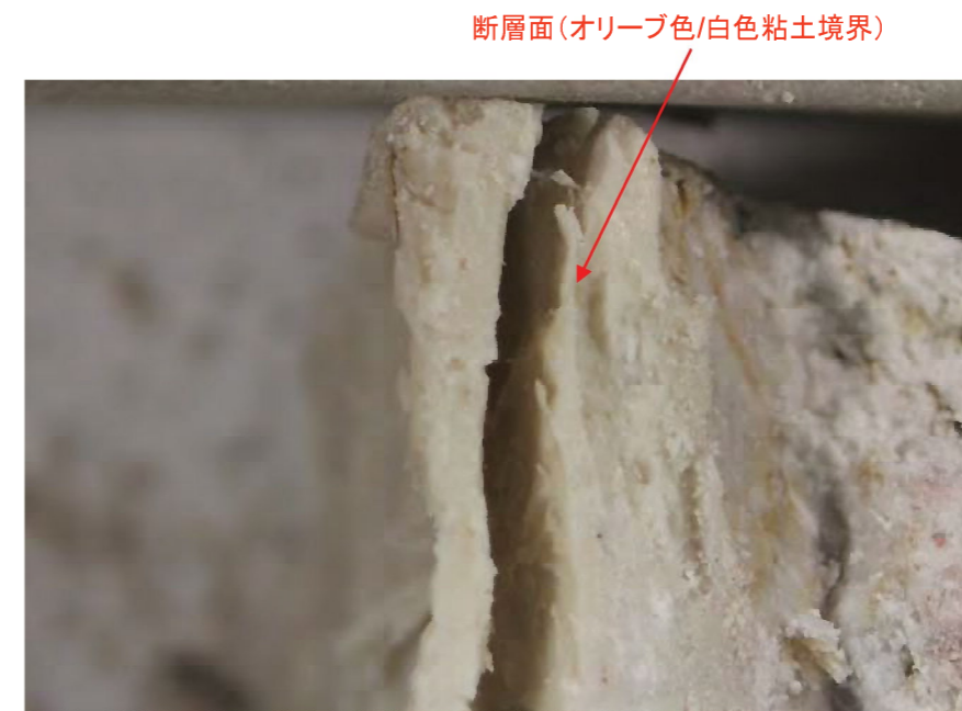
断層面の断面写真
