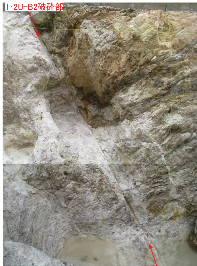
1・2U-B2 破碎部 山側壁面の写真
