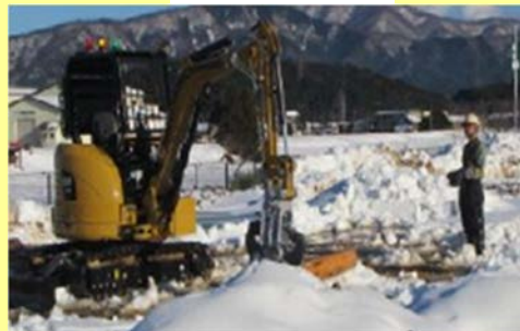
無線重機訓練
