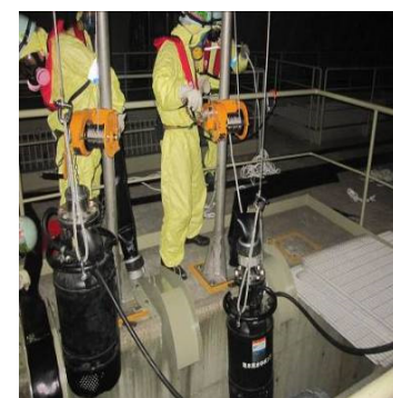
取水用水中ポンプの設置訓練
