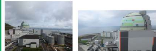
2号炉タービン建屋屋上
