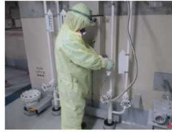
(制御用空気供給弁閉操作イメージ)
