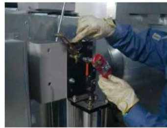
(空気作動ダンパ閉作業イメージ)
