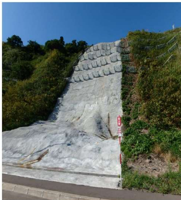
図1 防火帯モルタル吹付工の施工例
