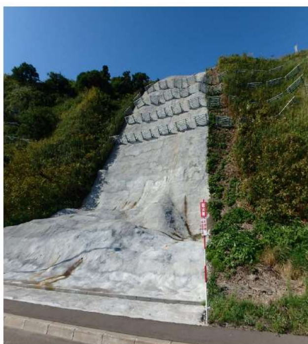
図1 防火帯モルタル吹付工の施工例
