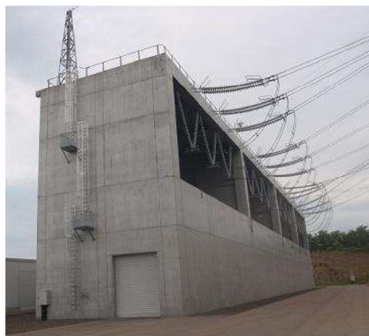
図1 開閉所（遮風建屋）
