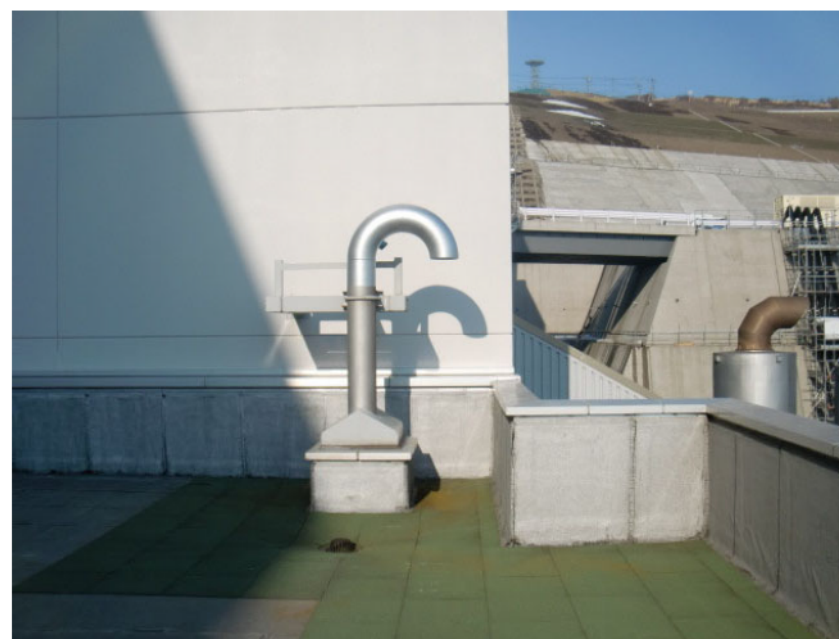
図5 タービン動補助給水ポンプ排気管の設置状況
