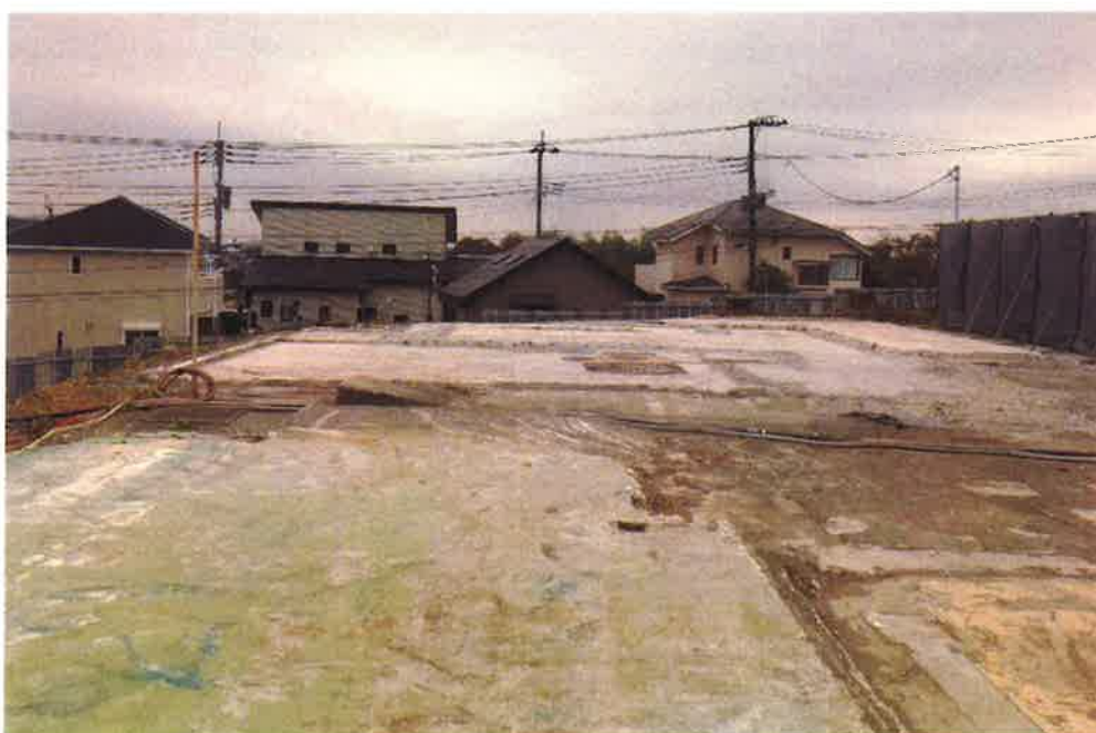
(2) B1A棟倉庫の解体後
