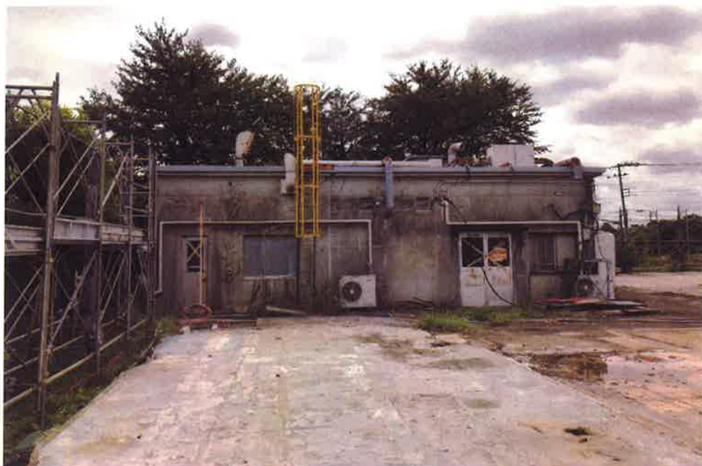
(1) B1A棟倉庫の解体前
