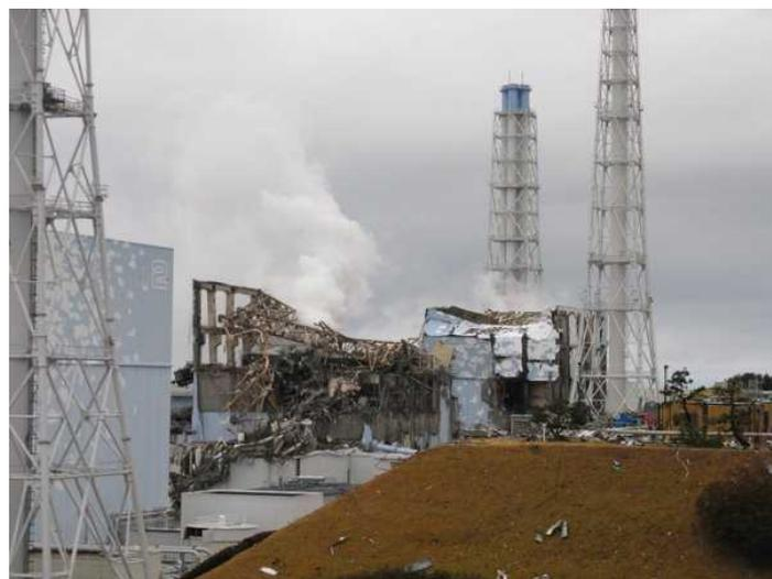
図2 2011年3月15日の4号機原子炉建屋の状況(その1)<sup>7</sup>
