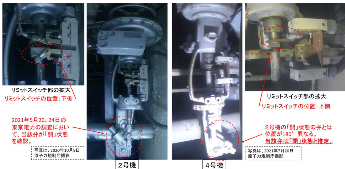
図4 2号機及び4号機西側原子炉キャビティ差圧調整ライン 空気作動弁調査(外観調査)
