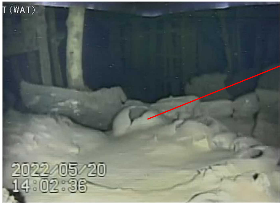
図9 ペDESTAL外周部の PCV 床面の堆積状況
