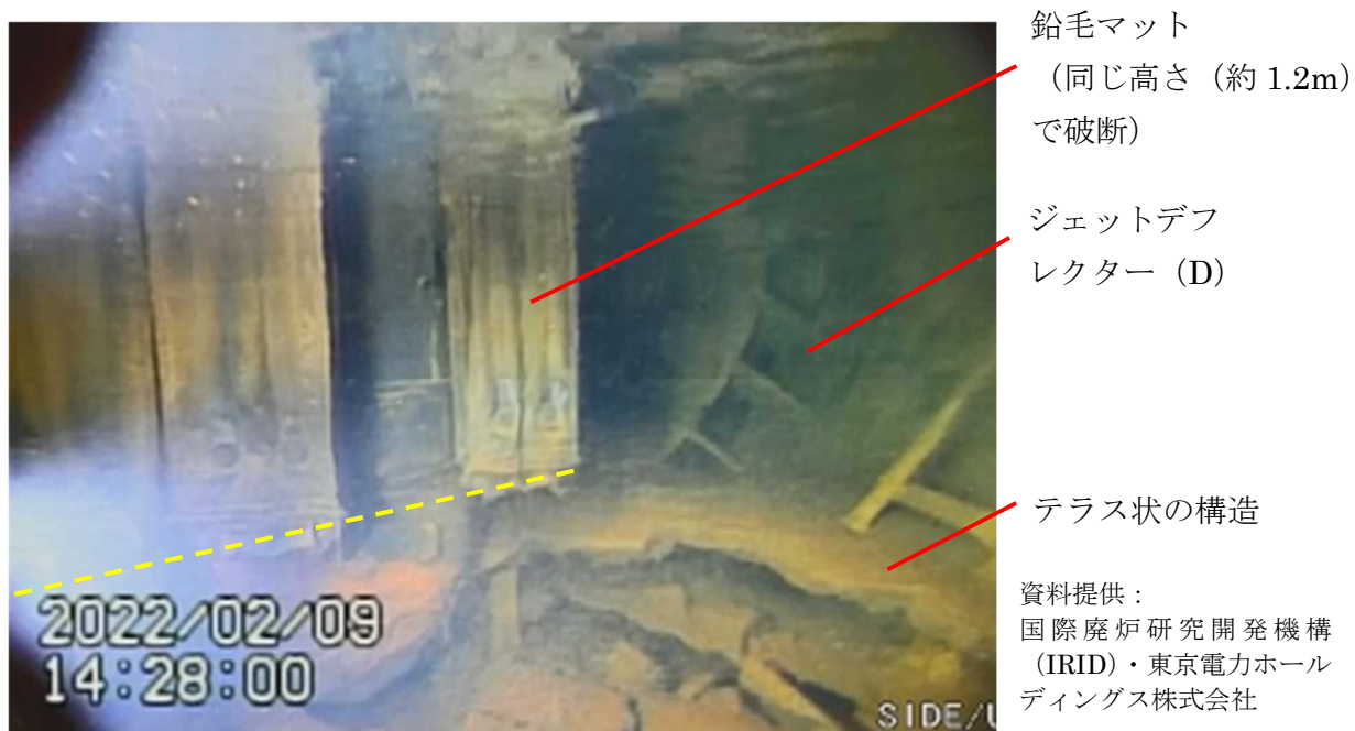
図5 ペDESTAL外周部（開口部付近）
