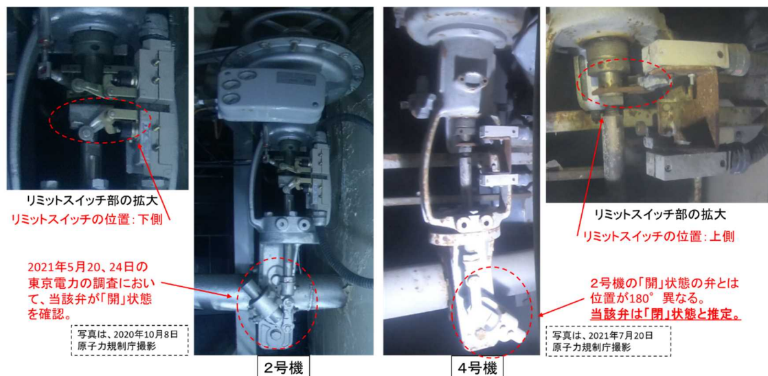
図4 2号機及び4号機西側原子炉キャビティ差圧調整ライン 空気作動弁調査(外観調査)
