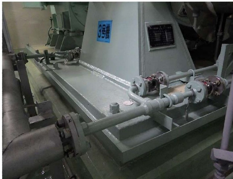
図19-3 3A余熱除去ポンプ, 3B余熱除去ポンプ 漏洩拡大防止措置
