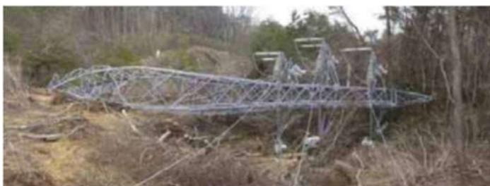
地震による斜面の崩落に伴う送電鉄塔の倒壊事例<sup>※2</sup>
