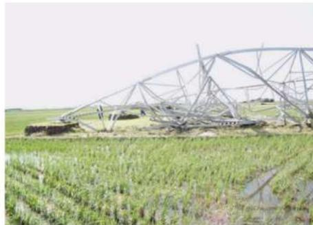
強風による送電鉄塔の倒壊事例①<sup>※1</sup>
