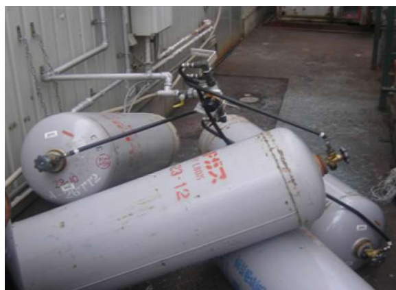
図14 東日本大震災でのLPガスボンベの被災状況※
