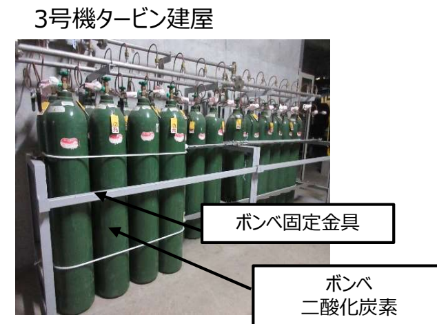
図15 発電所におけるボンベの設置状況
