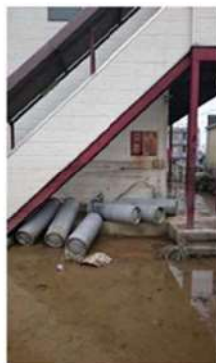
東日本豪雨（常総市の水害）でのLPガスボンベの被災状況の一例 3)
