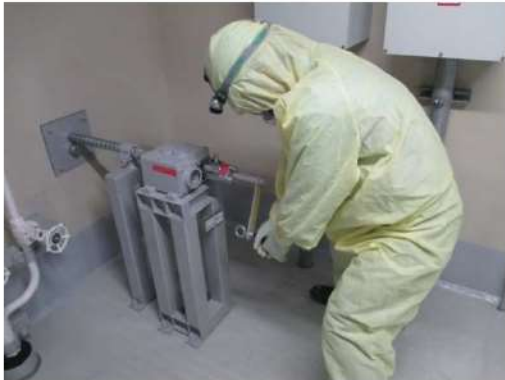
アニュラス排気ダンパ現場手動操作 (原子炉補助建屋 T.P. 40. 3m)
