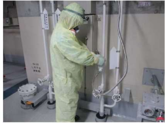
(制御用空気供給弁閉操作イメージ)
