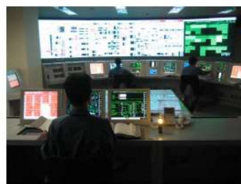
全交流動力電源喪失を想定した訓練
