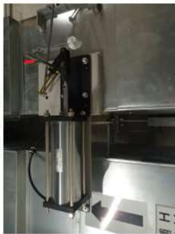
中央制御室排気隔離ダンパ
