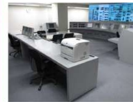
通常点灯時 (運転員点灯及び制御室運転員点灯)
