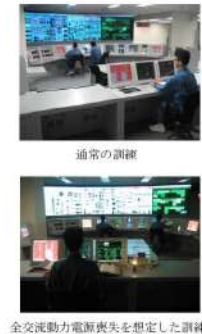
図2.5-6 無停電運転保安灯下で対応操作の確認（訓練）
