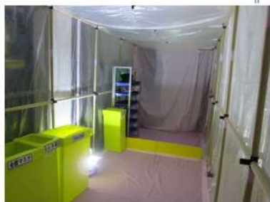
可搬型照明①
