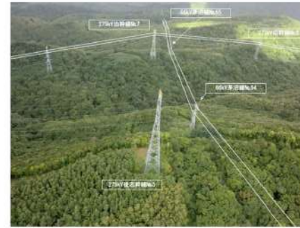
第2.2.3.5図 ③交差箇所の現地状況 (1/3)
