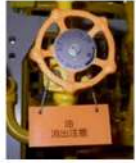
油類に係る弁 弁の識別
