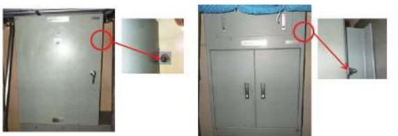
図2 電源盤のボルトによる壁面固定
