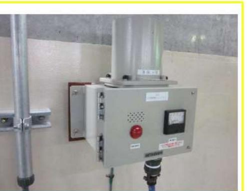
図2 機器のボルトによる壁面固定
