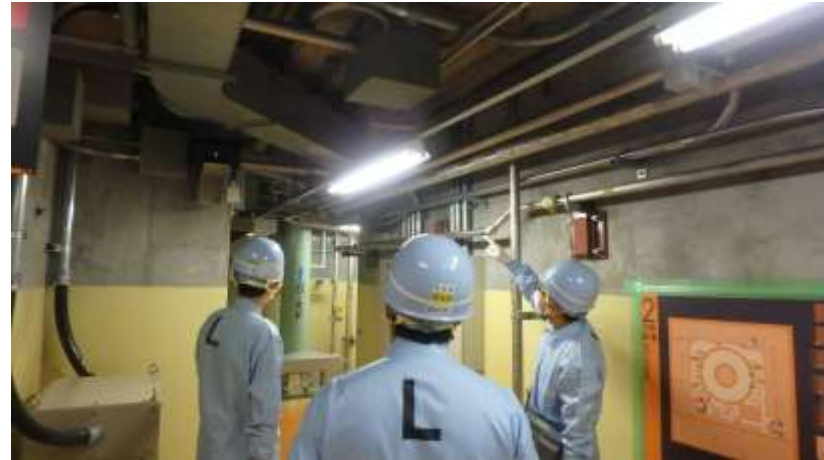
現場確認の例②
