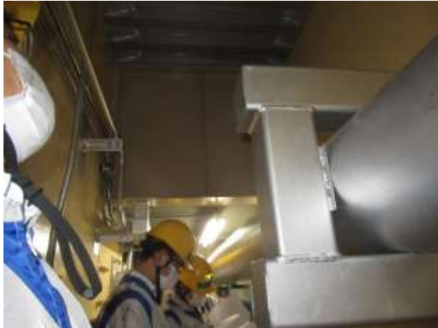
現場確認の例①
