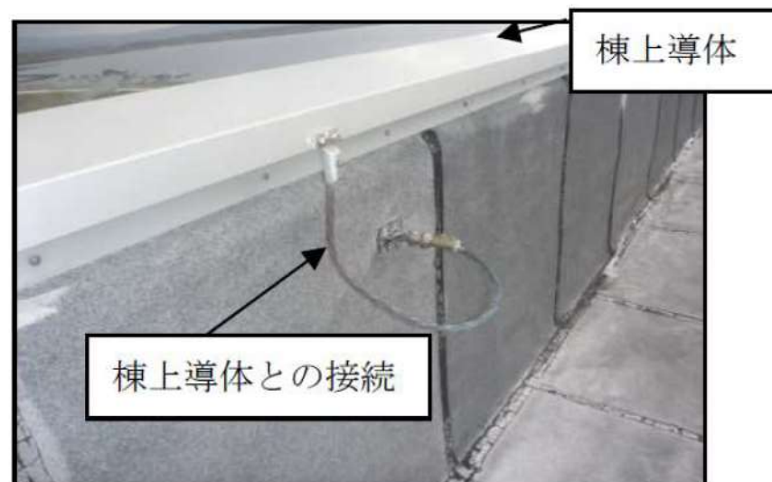
循環水ポンプ建屋
