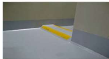
堰（ほう酸ポンプ室出入口）
