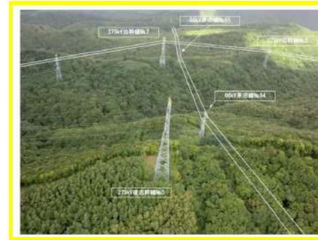
第2.2.3.5図 ③交差箇所の現地状況 (1/3)
