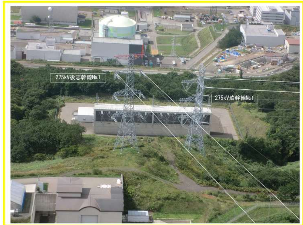
第 2.2.3.3 図 ①近接箇所の現地状況 (1/3)
