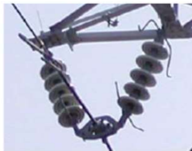
第2.2.4.8図 懸垂碍子化の施工状況
