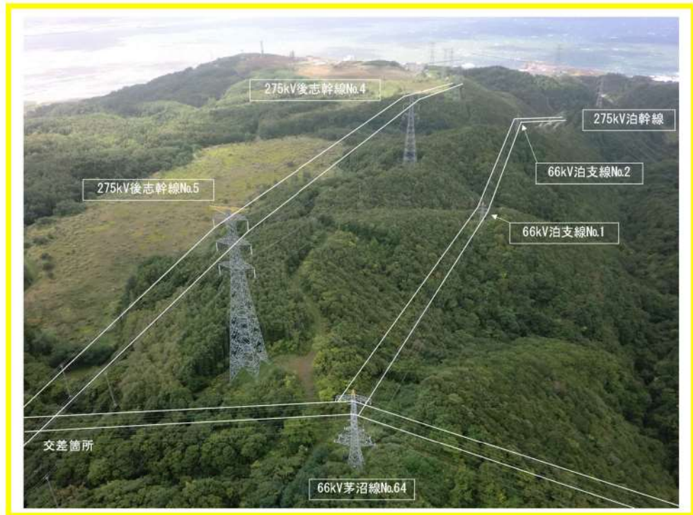
第 2. 2. 3. 6 図 ④交差・近接箇所の現地状況 (1/3)
