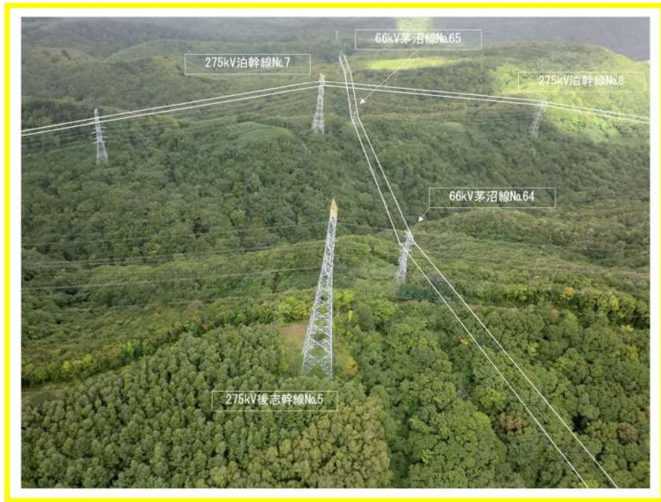
第 2. 2. 3. 5 図 ③交差箇所の現地状況 (1/3)
