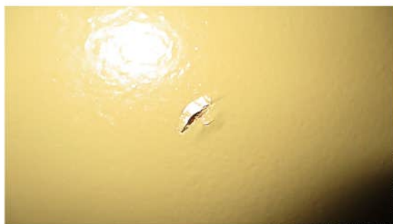
判定フロー②と判断した塗膜の劣化（1号炉） 判定フロー③と判断した塗膜の劣化（2号炉）
