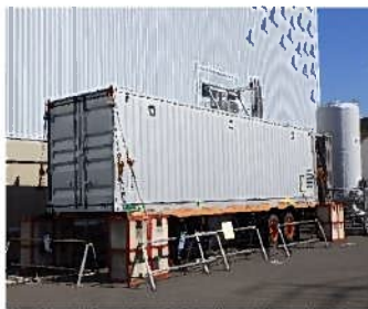
建屋外にある 遠隔操作用コンテナハウス
