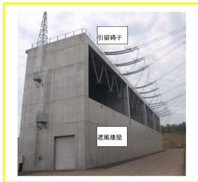
第 5.1 図 275kV 架線部 (引留碍子)
