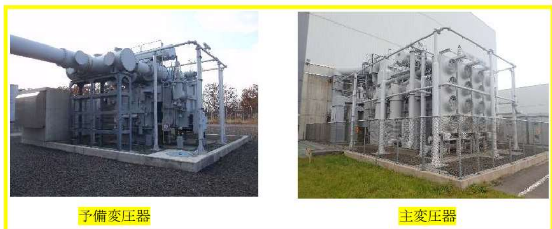
第2.2.1.10図 変圧器1次側接続部
