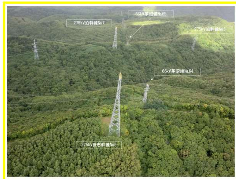
第 2. 2. 3. 5 図 ③交差箇所の現地状況
