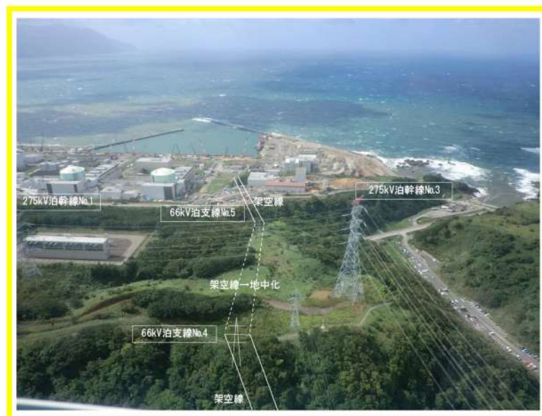
第 2. 2. 3. 4 図 ②交差箇所の現地状況
