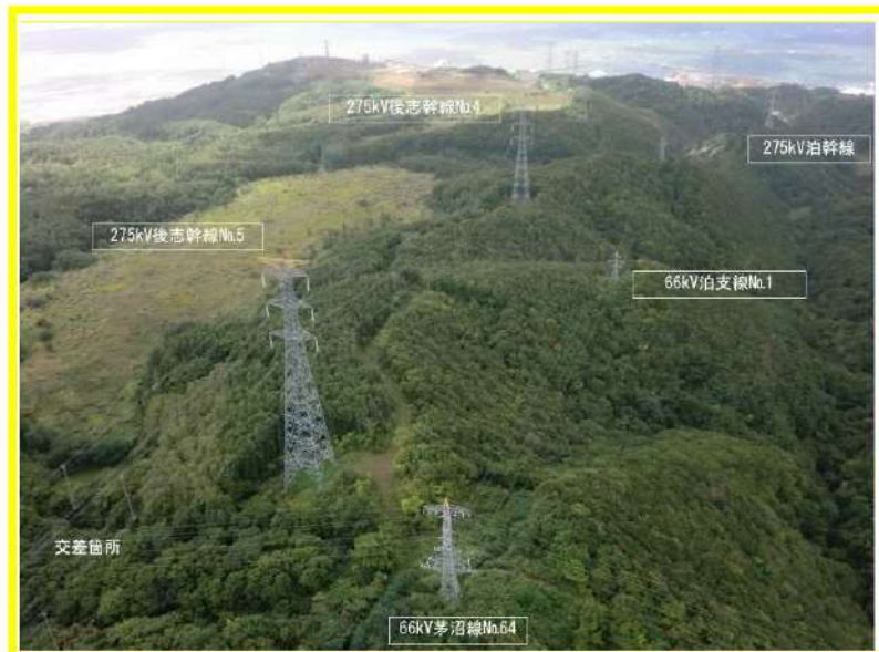
第 2. 2. 3. 6 図 ④交差箇所の現地状況
