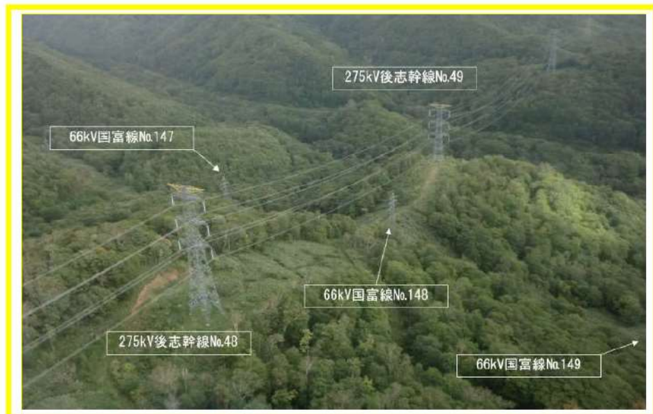
第 2. 2. 3. 9 図 ⑦交差箇所の現地状況
