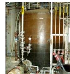
排水処理設備の例 (廃液槽)
