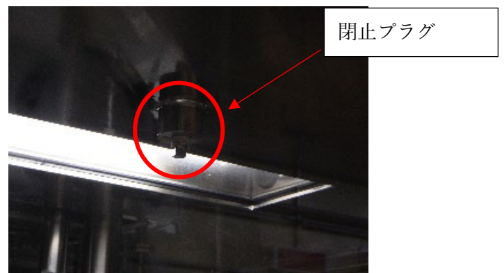
図-2 低放射性グローブボックス消火配管接続口 (内側)
