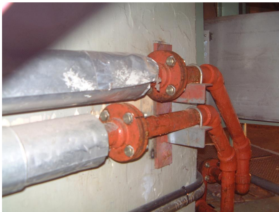
開口部左側側面における2本のRCW配管 (上下の配管の高低差は約20cm)
