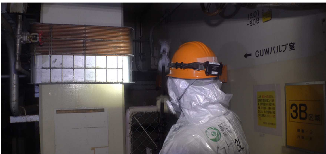
図 18 原子炉冷却材浄化系バルブ室付近
