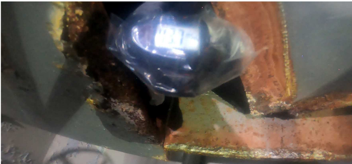
図 16 測定対象配管付近の線量率
