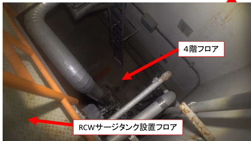
RCWサージタンク設置フロアから4階フロアを覗いた様子
