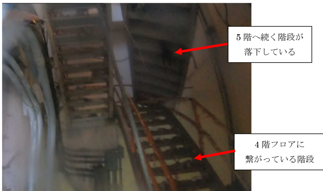
図 22 4階から5階に向かう階段の状況 (北西側)
