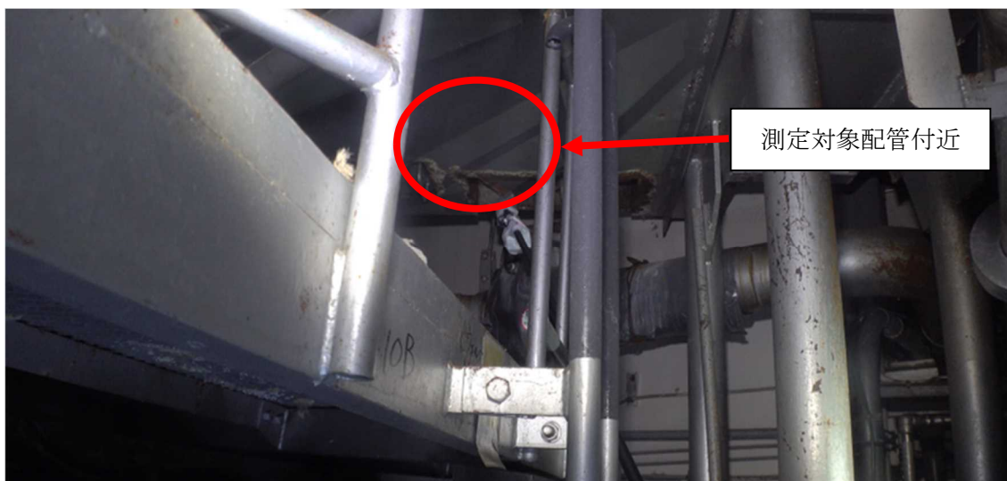
図 14 測定対象配管周辺の状況
