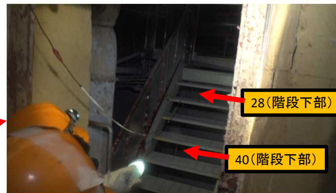
トラス室入口 (2022年12月22日原子力規制庁撮影)
