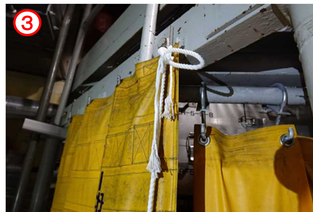
(ペDESTAL出入口付近)
