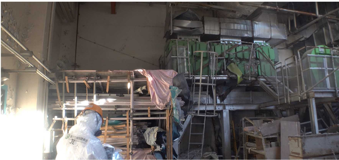
図 38 資機材・構造物の状況
