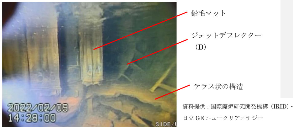
図7 1号機ペデスタル外周部（開口部反対側付近）
