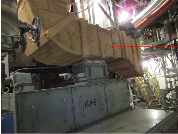
図9 ドライウェル空調用ダクト（ポリイミド発泡体保温材）の設置状況
