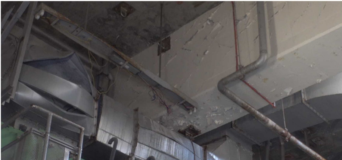
図 36 天井付近のダクト及び梁
