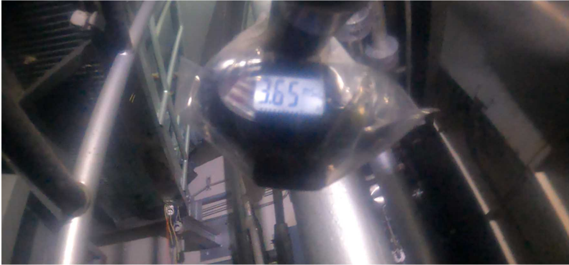
図 15 測定対象配管周辺の線量率
