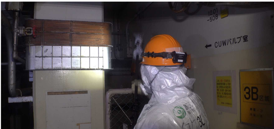
図 18 原子炉冷却材浄化系バルブ室付近
