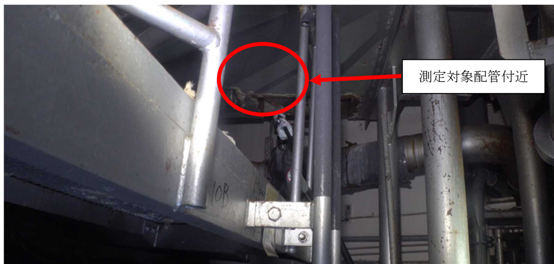
図 14 測定対象配管周辺の状況
