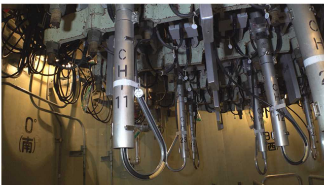
図 16 原子炉圧力容器下部 (複合ケーブル (PIP ケーブル) 等) の設置状況 (1)
