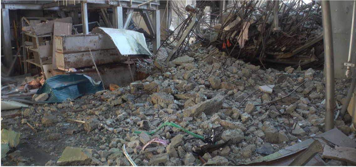
図 29 IC 北側付近のフロアの状況
