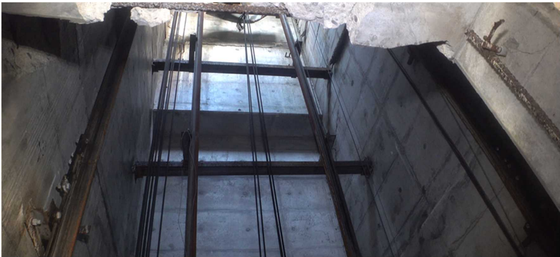
図 26 エレベータ室内（上方）（1号機原子炉建屋4階）
