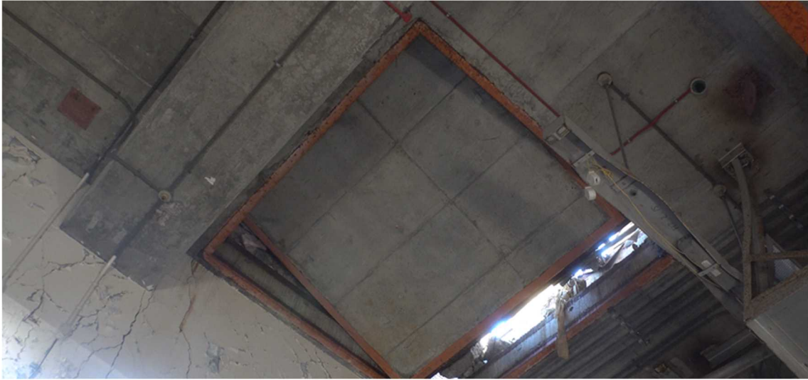
図 33 IC の北側の壁に近い天井（天井のハッチが外れている）
