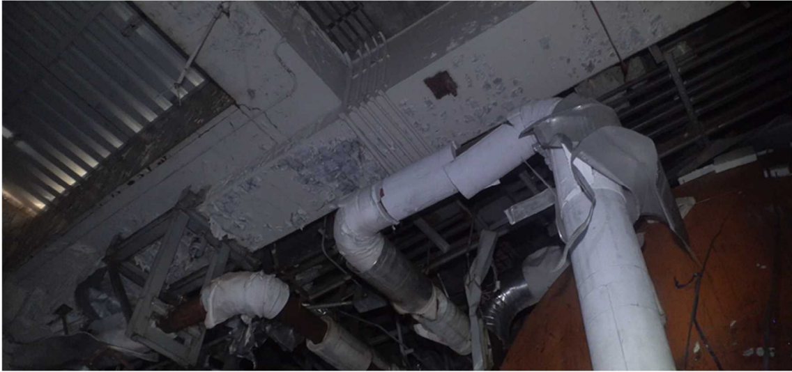
図 47 IC の南側付近の梁（1号機原子炉建屋4階） （IC（A系とB系の間）の上部）
