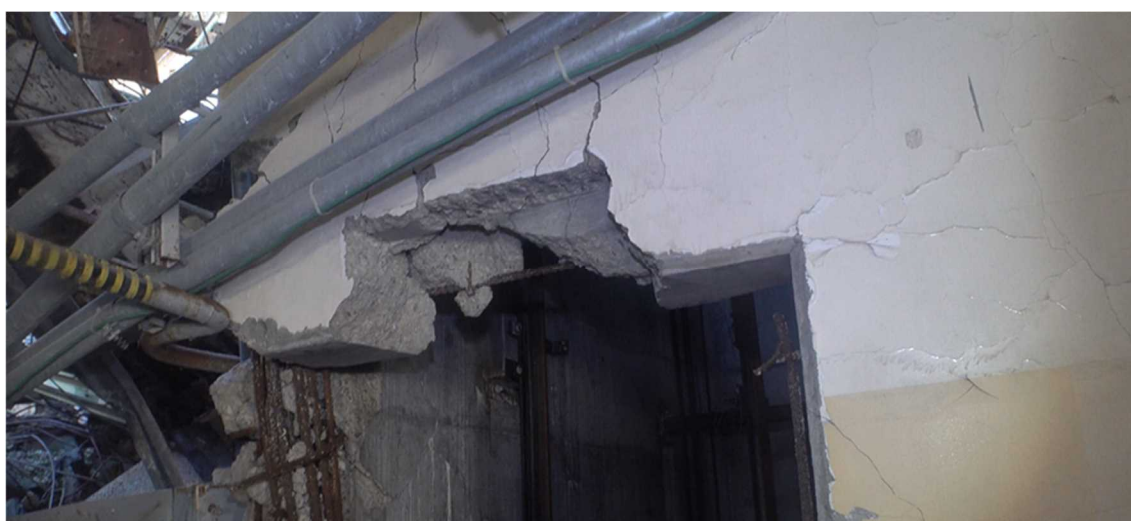
図 24 エレベータ室入口付近（1号機原子炉建屋4階）
