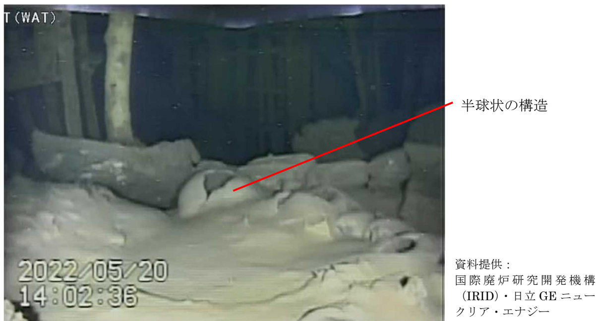
図9 ペDESTAL外周部の PCV 床面の堆積状況
