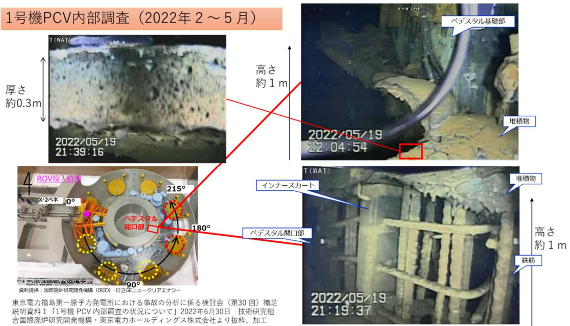
図4 1号機PCV内部調査②
