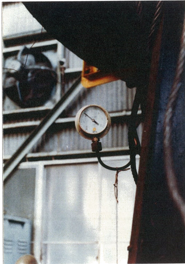
写真3 耐圧タンク内 圧力設定状況
