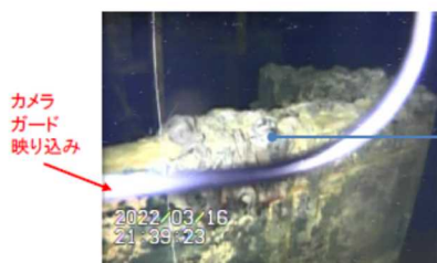
図 21-6 構造物に付着する堆積物②
