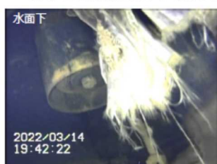
損傷した鉛毛マットカバーの グラスファイバー
