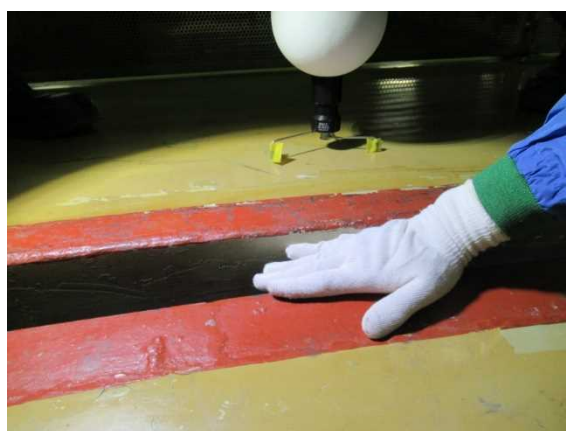
図 2 0 東端と DSP 側床面 (右図の左端) との間の状況 10
