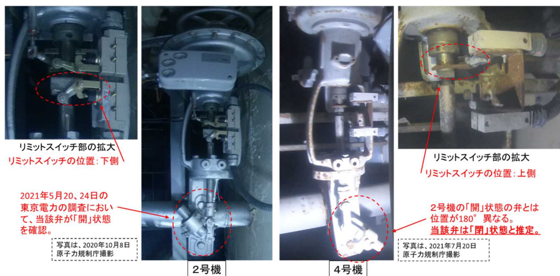
図 1 3 2号機及び4号機西側原子炉キャビティ差圧調整ライン 空気作動弁調査（外観調査）
