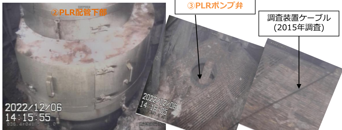
PCV内部1FLグレーチング上面
