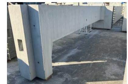
上流水槽隔壁
