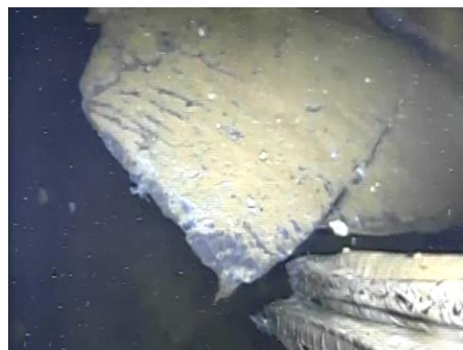
E: 真空破壊弁からの水漏えいが確認された バント管のジェットデフレクター
