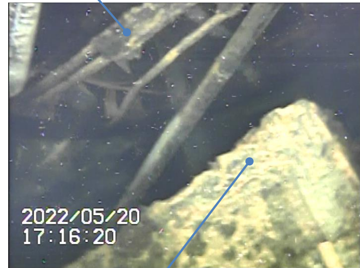
水中の構造物に付着した堆積物 (機器ドレンサンプの遮蔽体)
