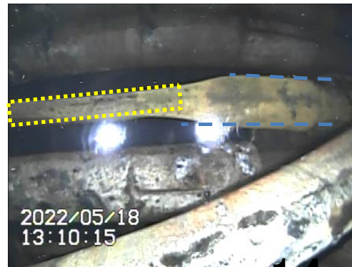
水面より上のRCW配管の状況
