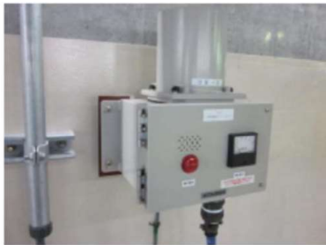
図2 機器のボルトによる壁面固定
