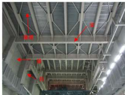
燃料取扱棟の屋根、梁、柱、壁
