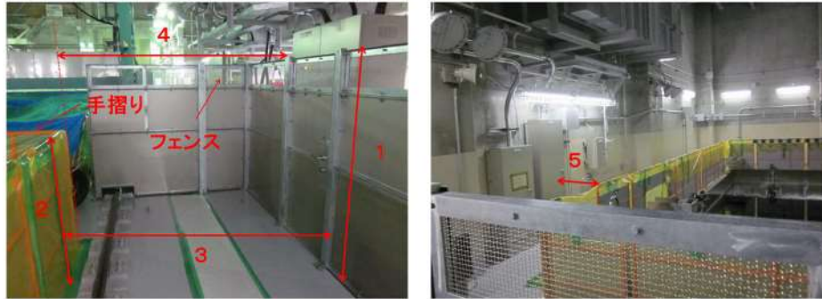
使用済燃料ピットとフェンス、手摺りの距離
